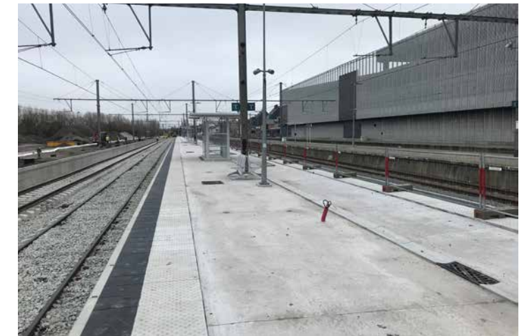
De vezels worden in de betoncentrale ingemengd in het beton. Dat zorgt voor bijzonder veel tijdswinst omdat er geen staalwapening geïnstalleerd moet worden on site.
